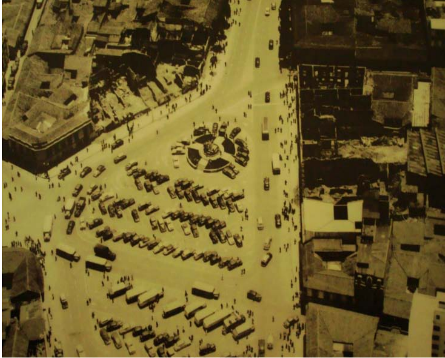
Figura 15 Aspecto general Plaza de San Victorino.
