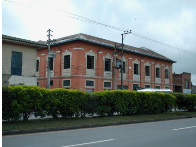
Figura 11 Edificación relacionada con la actividad ferroviaria Fuente: Imagen obtenida por el investigador.
