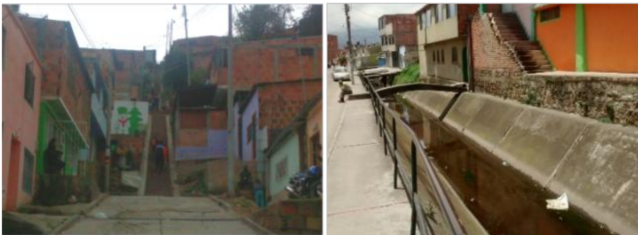
Figura 14. Zona urbanizada sobre pendiente mayor a 45 grados en el sector Cartagenita (izquierda), asentamientos humanos en zonas de ronda de la Quebrada El Vino en el barrio Los Molinos (derecha). Fuente: La autora.
