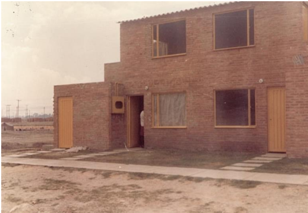
Figura 20 Construcción de la urbanización Compartir Fuente: Suacha conexión (Createga, 2015)
