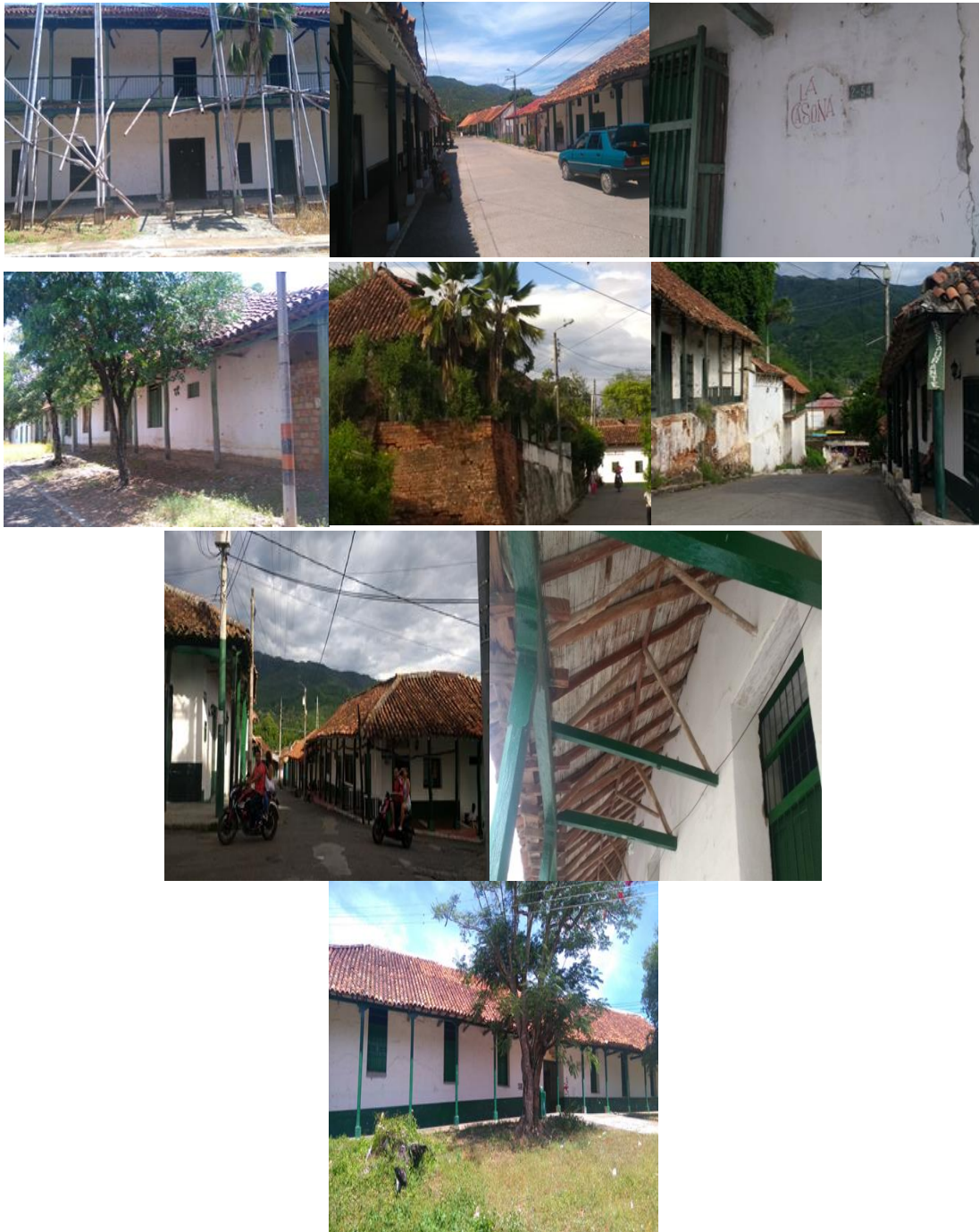
Figura No. 29. Edificación tradicional. Las edificaciones más antiguas de Ambalema, por las cuales es reconocida a nivel nacional, con una homogeneidad en sus elementos constitutivos, acentuada por los colores blanco y verde, fue fomentada, en gran medida, por la actividad tabacalera en el siglo XIX. hhh
