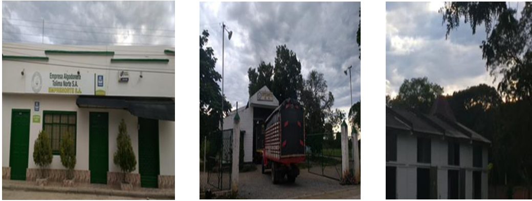
Figura No. 22. Instalaciones de EMPRENORTE S.A.
