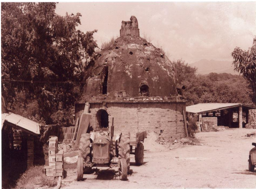
Figura No. 27. Ladrillera La Minita. Localizada en el área rural, km 8 vía a Armero, esta ladrillera es la más representativa del municipio.
