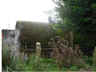
Figura 17: Silo de almacenamiento de trigo y cebada, abandonado.
