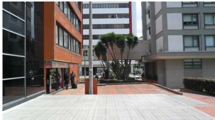
Figura 64. Fotografía. Callejón calle 84 entre carreras 15 y 16.
