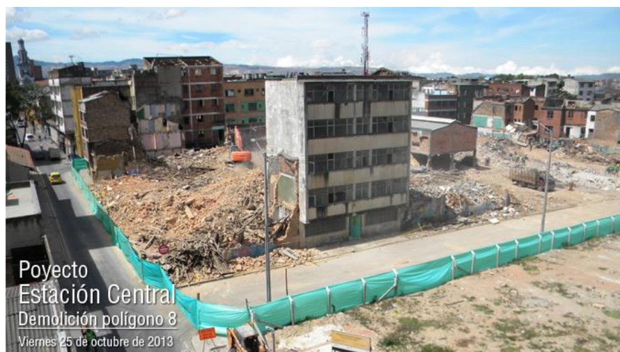
Figura 25. Vista demolición predios internos Proyecto Estación Central. Fuente ERU
