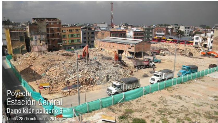
Figura 26. Vista demolición predios internos Proyecto Estación Central. Fuente ERU.
