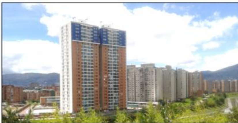
Fotografía de desarrollos de vivienda nueva posteriores a la implantación del Centro comercial Titán Plaza
